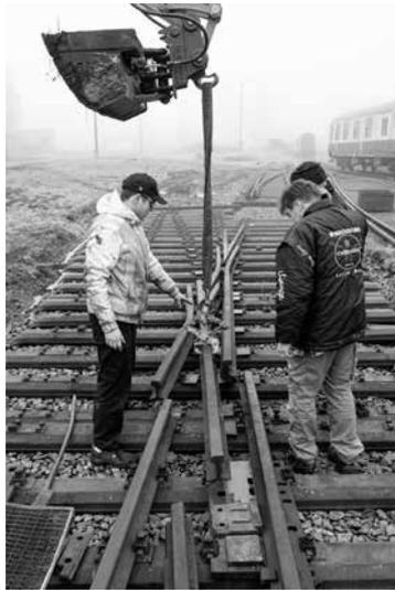
*Mit der Unterstützung schwerer Technik wurden die einzelnen tonnenschweren Schienenstücken auf die vorher ausgelegten Schwellen gehievt. (Foto: Bernd Hahn)*
